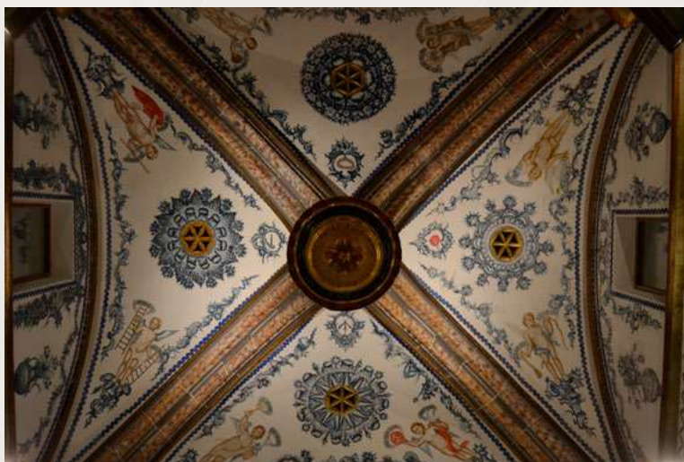
Bóveda del camarín tras su restauración.
