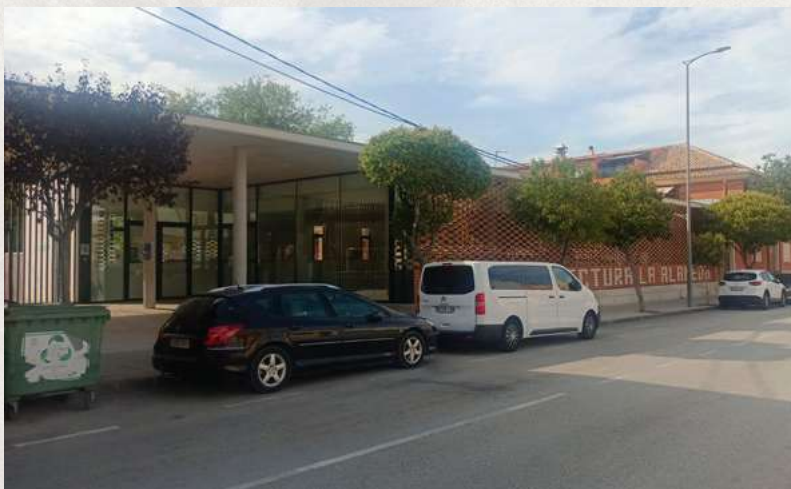
Yecla. Sala de Lectura “Alameda” (2019-2020) (FIG. 7), un modesto pabellón emplazado en la avenida de Córdoba, núm. 7, de sesgo minimalista diseñado según proyecto del aparejador municipal Sergio Santa Marco.
